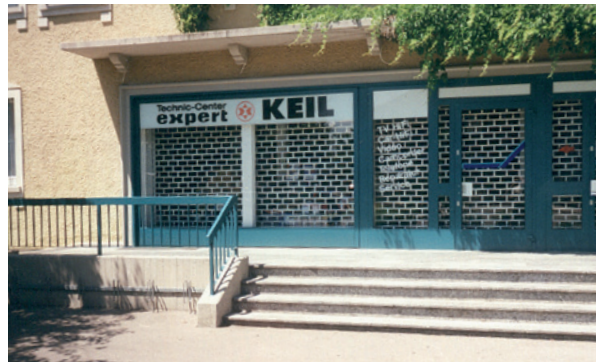
↗ Sicherung mit innenliegendem Rollgitter
